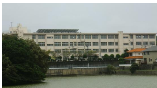
和白東小学校の屋上に設置されている太陽光パネル
