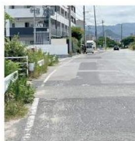
塩浜3丁目 路側帯カラー舗装
